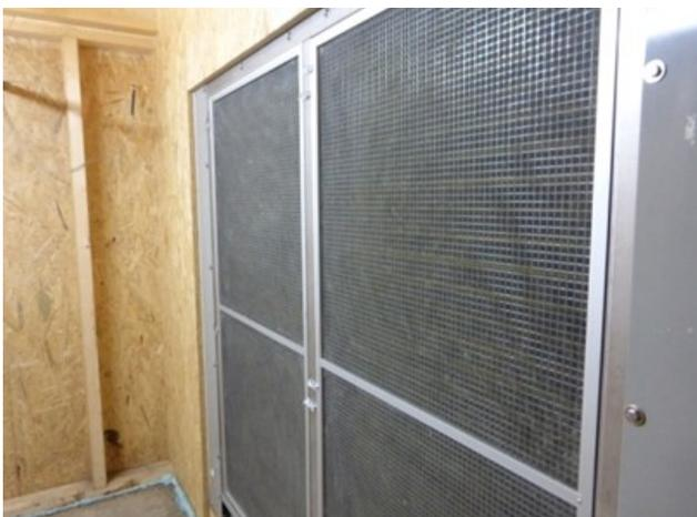
**Abb. 7:** Luftentfeuchter mit zuluftseitigem Gitter für den Grobschmutz an der Anströmseite des Wärmetauschers (Bildquelle: Markus Hofmann, LfL 2018)
