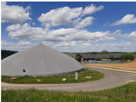
Abb. 5: Die 75 kW Biogasanlage mit dem Altstall.
